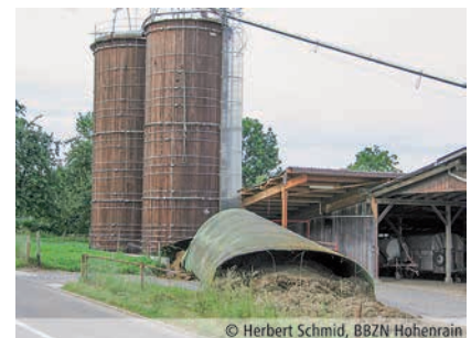
Hochsilos sind regelmässig auf Schäden zu kontrollieren, um das Risiko von Silostürzen zu minimieren.
